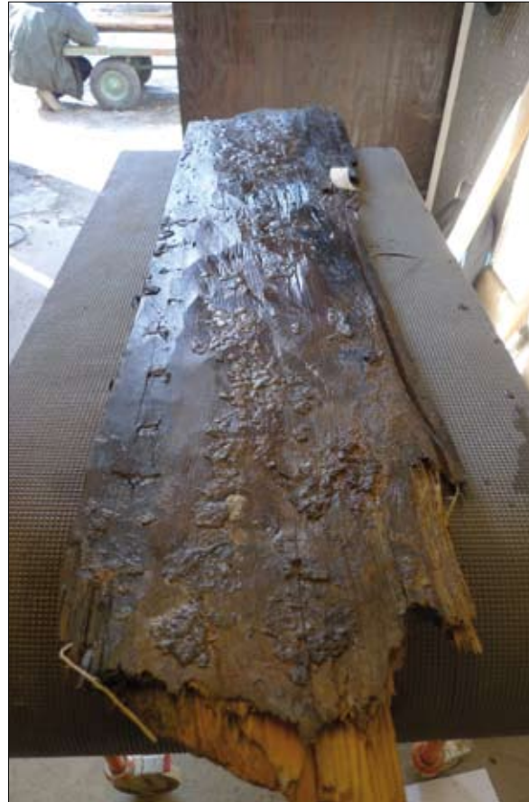
Fig. 5. Bordläggningsplanka som uppvisar tydliga märken efter handverktyg, förmodligen en bila. Notera även på bordets vänstra sida märkena efter de omböjda handsmidda spikarna. Foto Jim Hansson, Sjöhistoriska museet.
